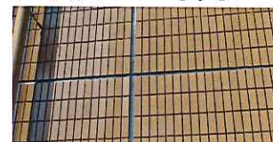
外壁コーティング
