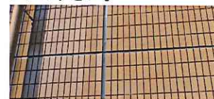
外壁コーティング
