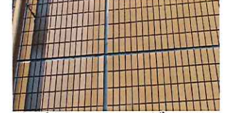
外壁コーティング
